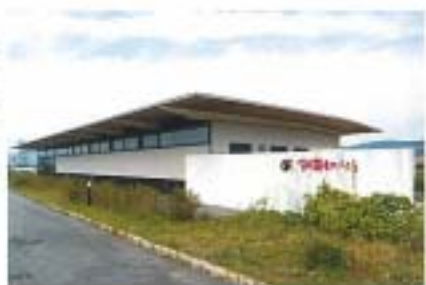
「阿蘇ものがたり」の工房。当初は、一の宮町の町安が移転した後に改装してスタート。現在は物産館「四季彩いものみや」の敷地内に、行政の事業の一環として建設された工房で製造を行っている。
